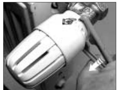
С помощью шестигранного ключа SW2 ввернуть два стопорных штифта. В этом положении термоголовка прочно закреплена на клапане, и зубчатое кольцо ② может свободно поворачиваться.
