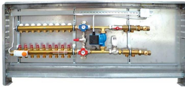
Для регулирования температуры помещения и существующего нагревательного контура отопления в распределительную коробку установлена электрическая колодка и произведен электромонтаж термоприводов и циркуляционного насоса.
