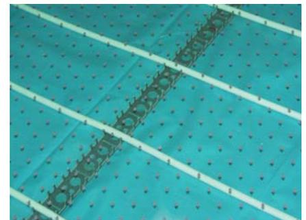
**Интервал размещения труб в обычной зоне**
