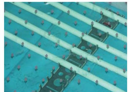
**Интервал размещения труб в краевой зоне теплого пола**
