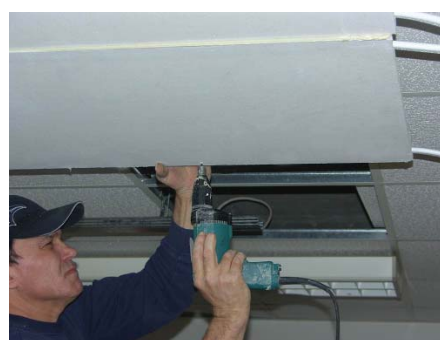
Монтаж потолочных охлаждающих панелей
