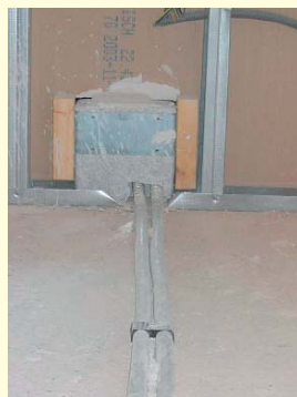
Пример: подключение от встраиваемых распределителей ГЕРЦ
